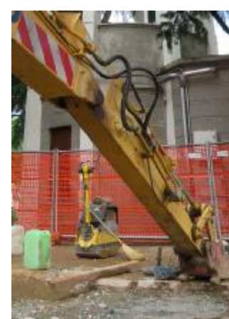
Uno scavo di Acque Veronesi
